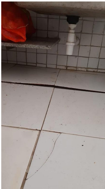
Foto 04 – Deslocamentos de peças cerâmicas no piso da cozinha;
