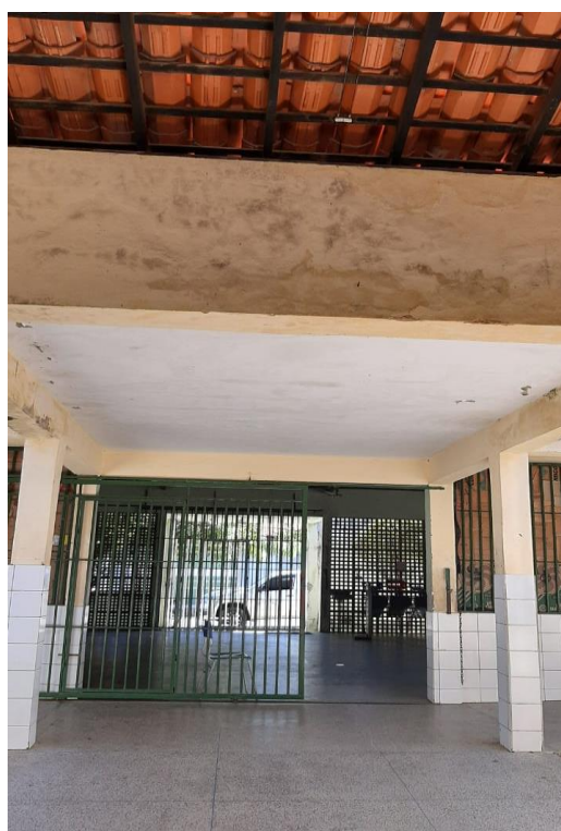
Foto 03 – Laje de cobertura com infiltrações;
