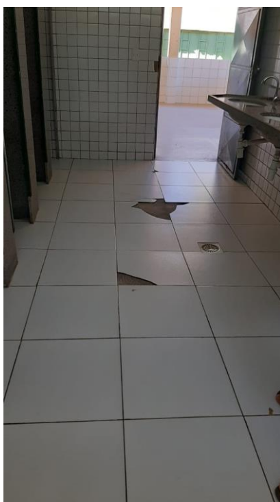
Foto 05 - Peças cerâmicas danificadas no piso do banheiro.
