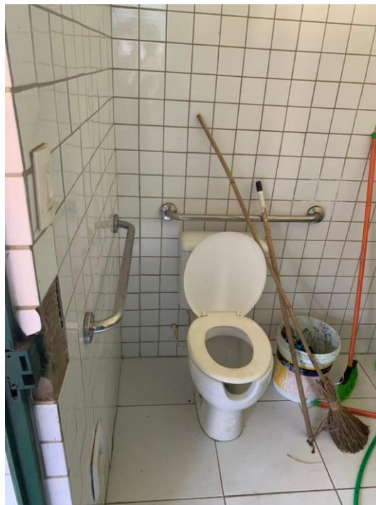
Foto 10 – Banheiros PCD com barras de apoio nas paredes;
